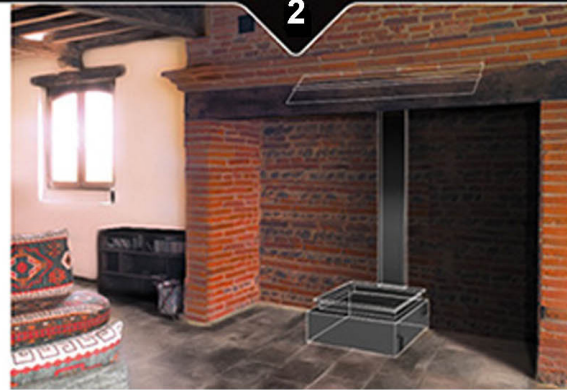
Posizionamento del focolare e della cappa di chiusura su misura
